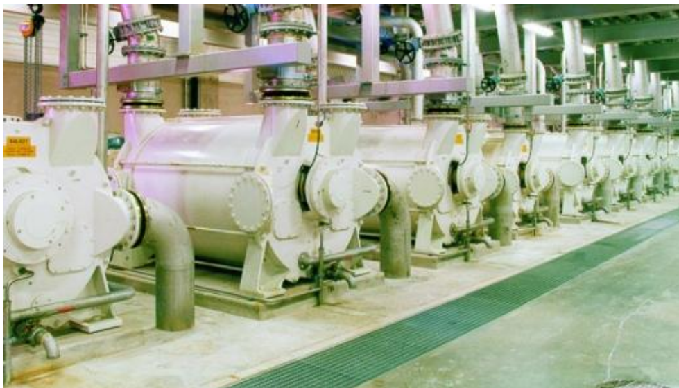
Figura 1: Instalação utilizando bombas de selo líquido para geração de vácuo.
